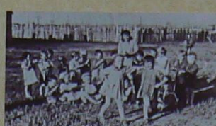
Землеподготовка на Александровской улице. ДЛ № 73, 1942 г.
